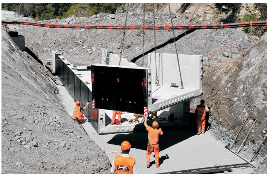
Zusammenstellen der vorgefertigten Elemente für die Unterführung Äuli
