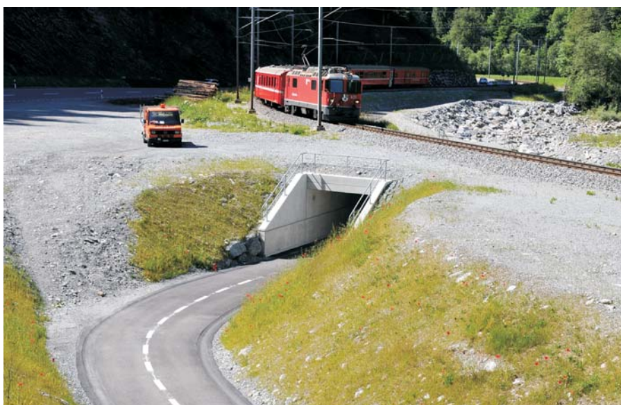
Die fertig hinterfüllte und eingedeckte Unterführung Äuli
