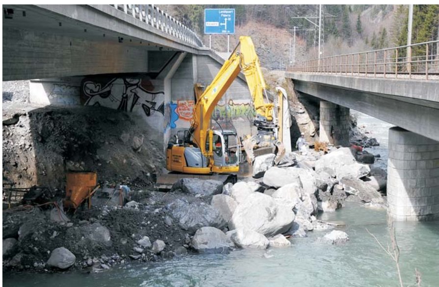
Bau der Stützmauerfundamente zwischen Bahn- und Strassenbrücke
