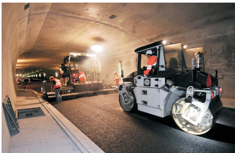
Einbau und Verdichten der Tragschicht
