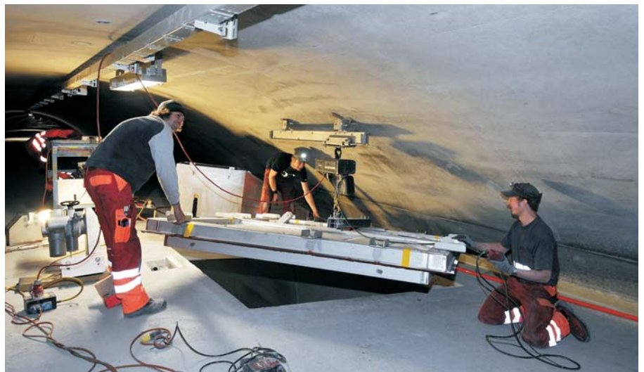
Montage einer Abluftklappe in der Zwischendecke
