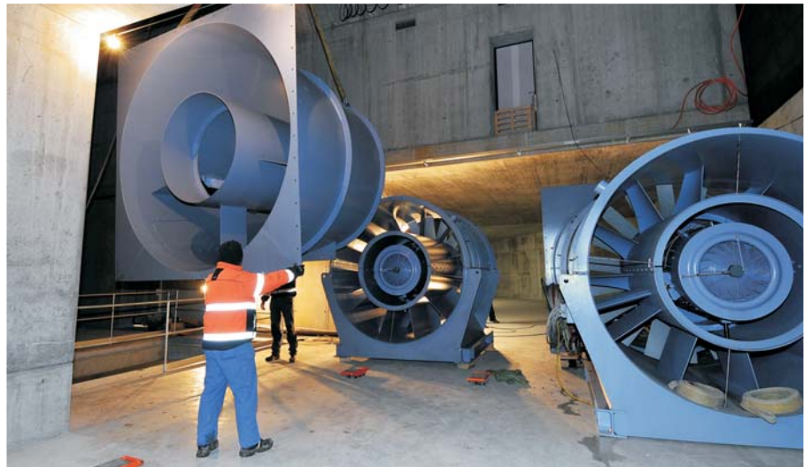
Einbau der mächtigen Abluftventilatoren
