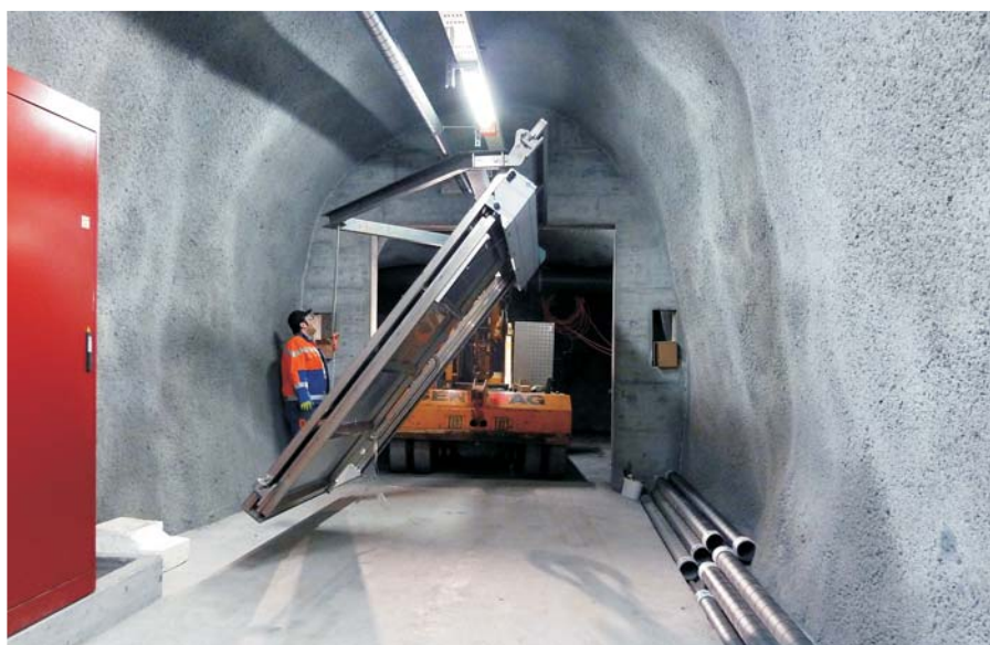
Montage der Schiebetüren zwischen Haupttunnel und Sicherheitsstollen
