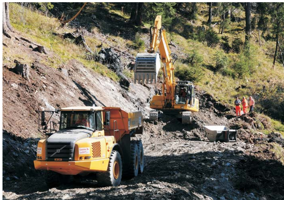
Bau der offenen Strecke zwischen der Abzweigung Tgiern und dem Tunnel Plattas
