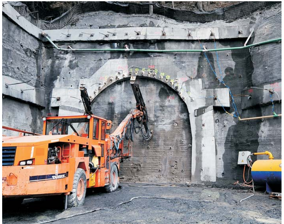
Voreinschnitt Tunnel Plattas, bereit für den bergmännischen Vortrieb.
