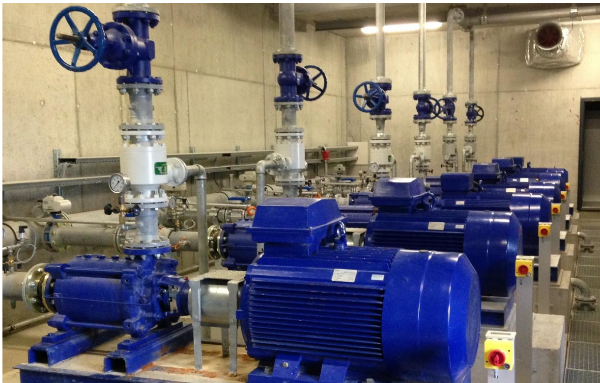
Abb. 37: Pumpengruppe für Beschneigungsanlagen, Quelle: Peter Müller
