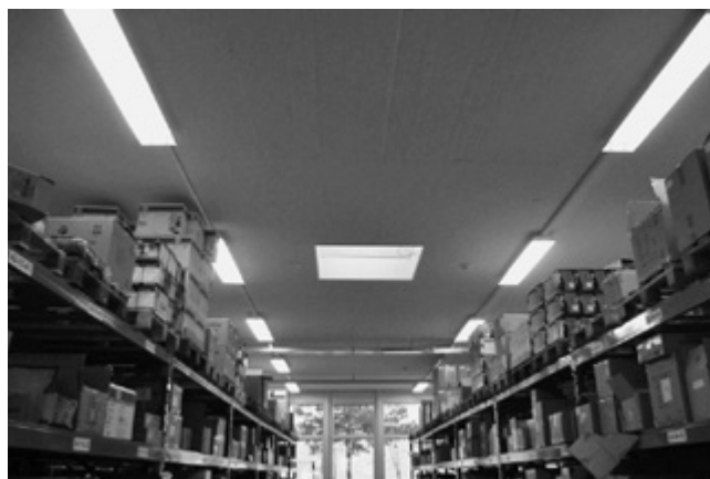
Abbildung 1: Beispiel der Beleuchtung in Materiallager
