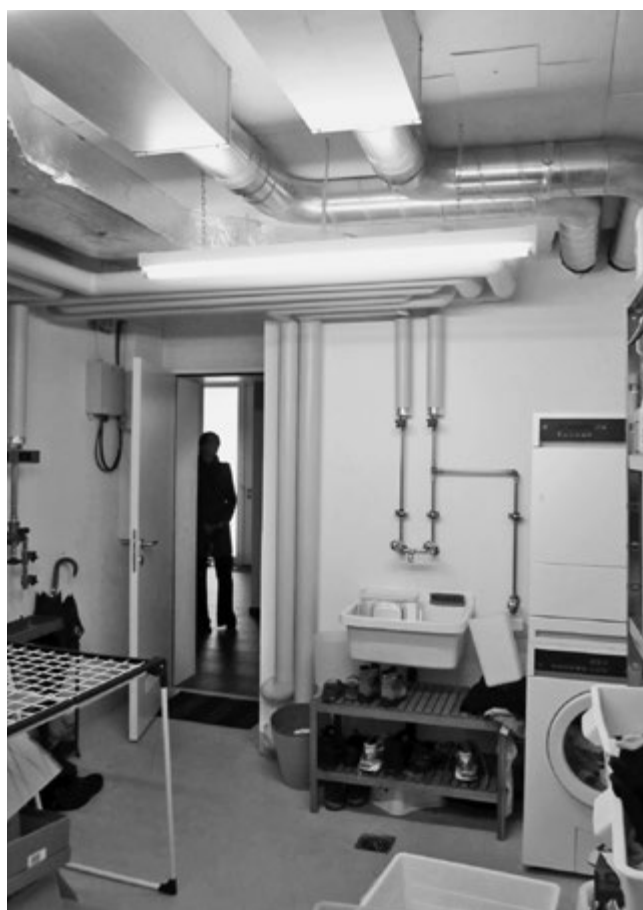
Abbildung 3: Technikraum ausserhalb der thermischen Gebäudehülle
