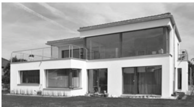
Abbildung 3: Oft ist es schwierig, in exponierten Räumen (hoher Glasanteil) die maximale Vorlauftemperatur von 35 °C einzuhalten.
