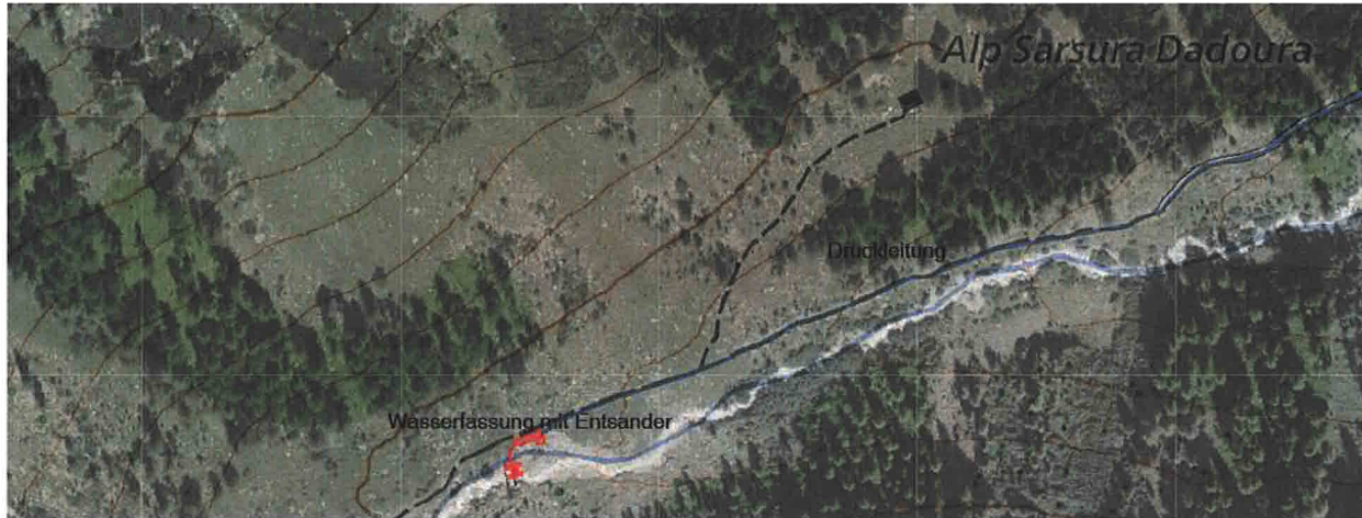
Abbildung 2: Wasserfassung mit dem Entsander, ca. 100m vom Wegabzweiger zur Alp Sarsura Dadoura gelegen
