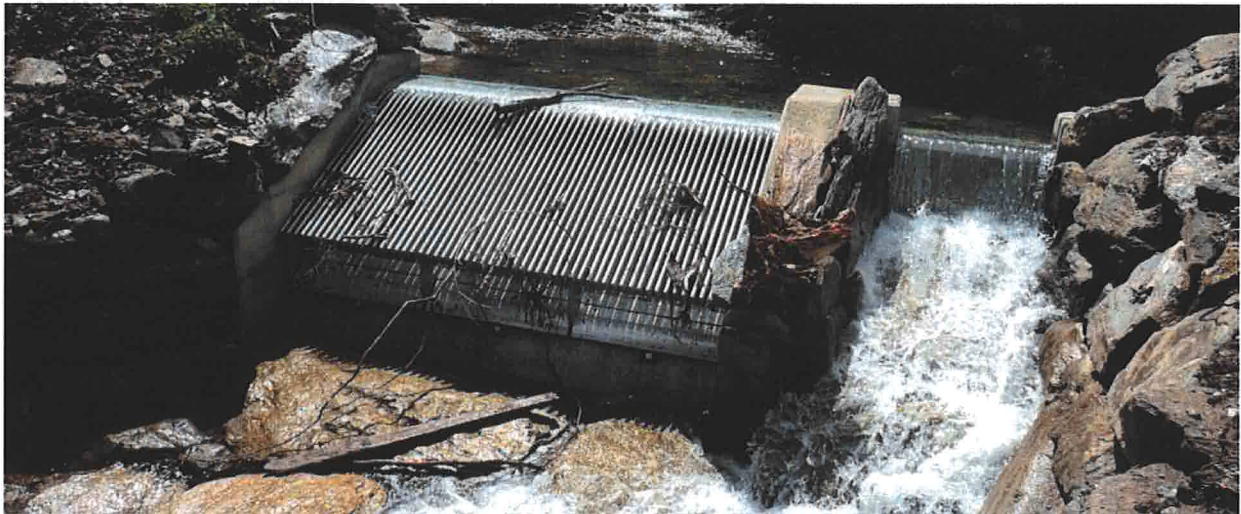
Abbildung 3: Beispiel einer Tirolerfassung mit Coandarechen, System Wild-Metall
