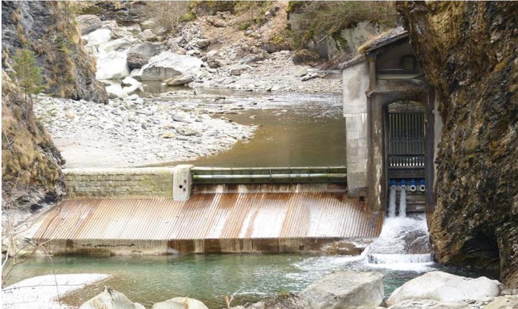
*Foto: Stauwehr unterwasserseitig mit Klappwehr und Grundablassschütz*
