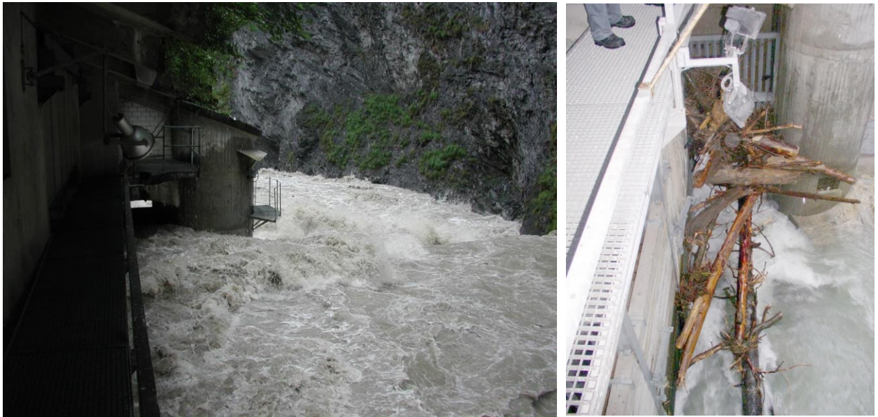
Abbildung 4: Hochwassersituation und Verklausung durch Schwemmholz
