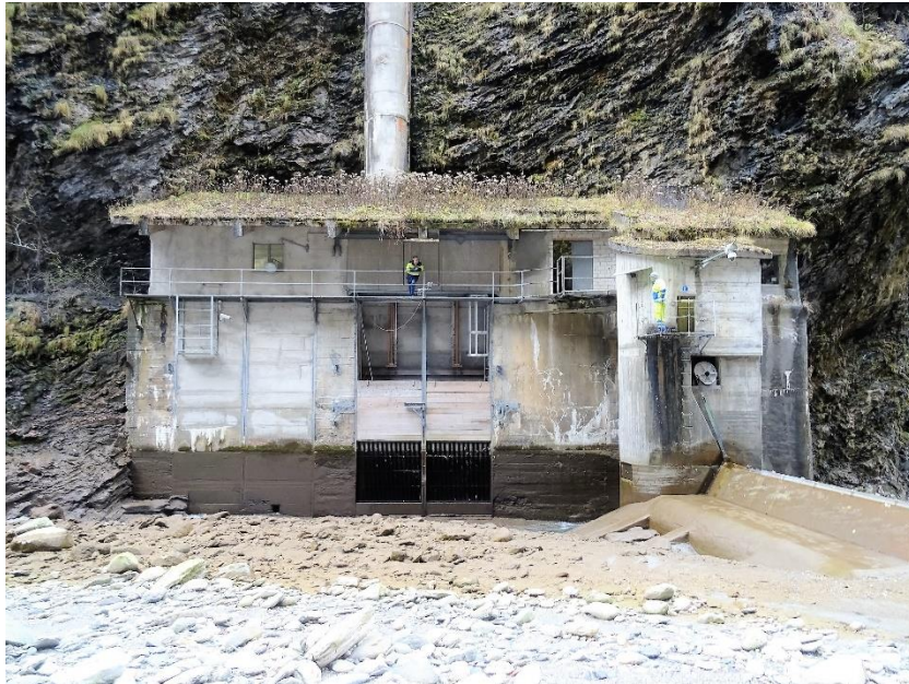
Betriebsgebäude mit Zugangsturm.
