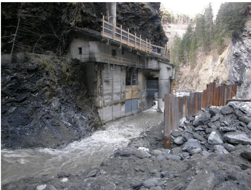
Betriebsgebäude mit Zugangsturm und Wasserhaltung Erneuerung 2014.
