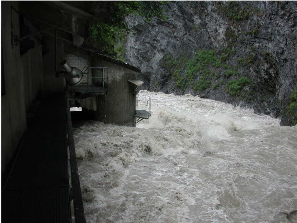
Abbildung 7: Hochwassersituation Fassung Rongellen
