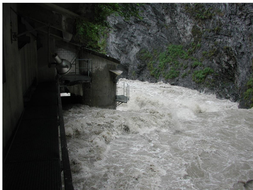
Blick auf Stauwehr Hochwasser.
