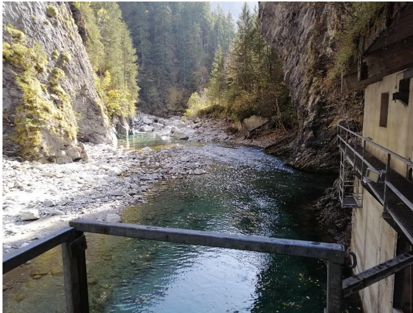
Blick flussaufwärts Niedrigwasser.
