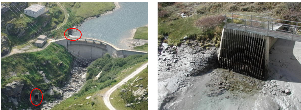
Abbildung 2-2: Bogenmauer Preda mit Auslass des Überleitstollens Avers – Madris sowie Auslass des Grundablasses ersichtlich (Foto links, rote Kreise) und Einlauf des Überleitstollens Madris – Valle di Lei (Foto rechts)
