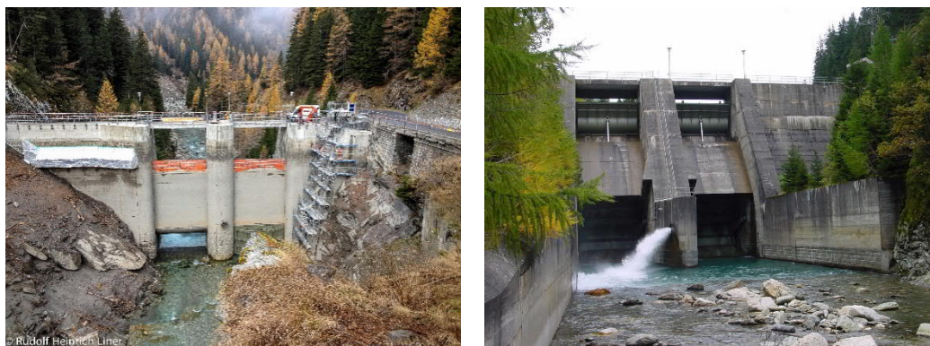
Abbildung 2-9: Gewichtsmauer Innerferrera mit Einlauf vom Druckstollen Wehr – Zentrale Ferrera bei leerem Becken (Foto links) und Gewichtsmauer vom Unterwasser mit laufendem Dotierungsauslass (Foto rechts)
