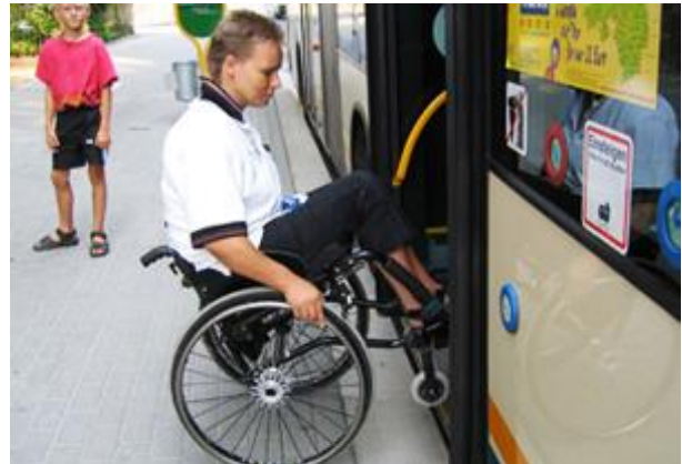
Haltekante mit Sonderbord, Höhe \geq 22 cm, max. zulässiger Restspalt: \Delta h \leq 5 cm, \Delta b \leq 7.5 cm
