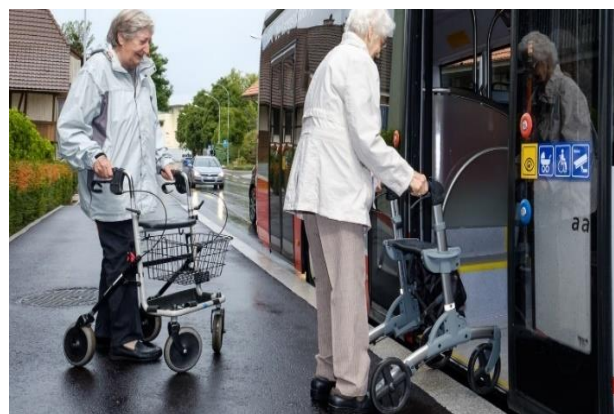
Haltekante mit Höhe 16 cm, damit Neigung der Klapprampe \leq 12\% (mit Hilfestellung max. 18\% )
