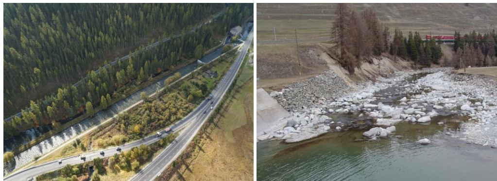
Abbildung 6-8: Links: Der Inn unterhalb des Kraftwerks Islas ist massgeblich durch die Regulierung der Abflüsse geprägt. Rechts: Tosbecken am Wehr der Wasserfassung S-chanf und Beginn der Restwasserstrecke
