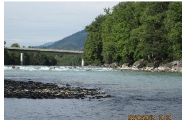
Abb. 3.6: Sohlrampe bei Felsberg (© ezb TB Eberstaller)
