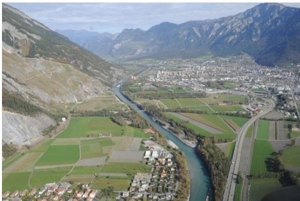
Abb. 3.5: Aufweitung bei Felsberg (© hydra)
