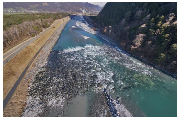
Abb. 3.10: Schwelle Ellhorn nach Sanierung BR flussab – Beginn Strecke RHE 4 (© hydra)
