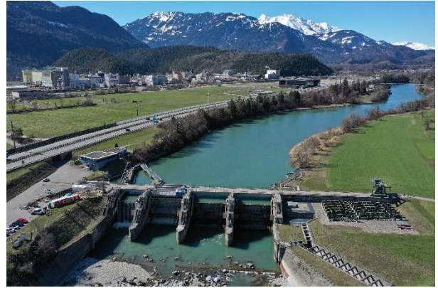
Abb. 3.4: KW-Reichenau - mit Stau und RW-Strecke (© hydra)
