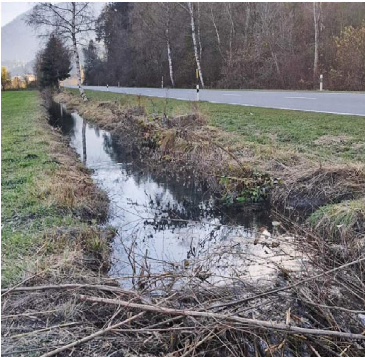
In der Nähe von Infrastrukturen können Biberdämme ein erhebliches Schaden- oder gar Gefährdungspotenzial bedeuten.
