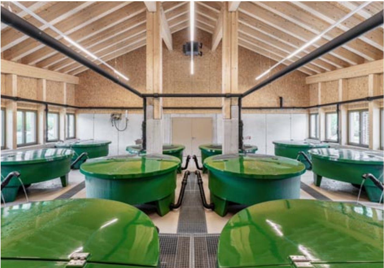
Ersatzneubau Fischzuchtanlage Klosters, Innenaufnahme der Rundstrombecken.
