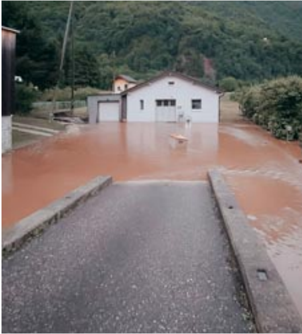
Kantonale Fischzucht in Cama während des Hochwassers.
