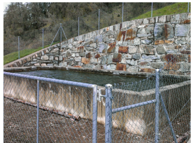
Wasserentnahmestelle aus Beton am Standort Val Irola oberhalb von Viano – Gemeinde Brusio.
