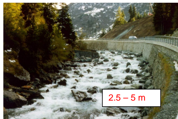
c) Uferschutz mit armierten Betonmauern mit genügender Foundationstiefe
