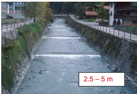
c) Uferschutz mit armierten Betonmauern mit genügender Foundationstiefe
