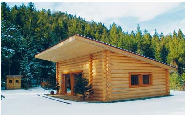
Tannenholz kann genauso gut im Holzbau verwendet werden wie Fichtenholz. Seine Verwendung bringt keine Nachteile für das Bauwerk. Im Bild oben das Blockhaus Bonaduz. (Heiri Mannhart)
