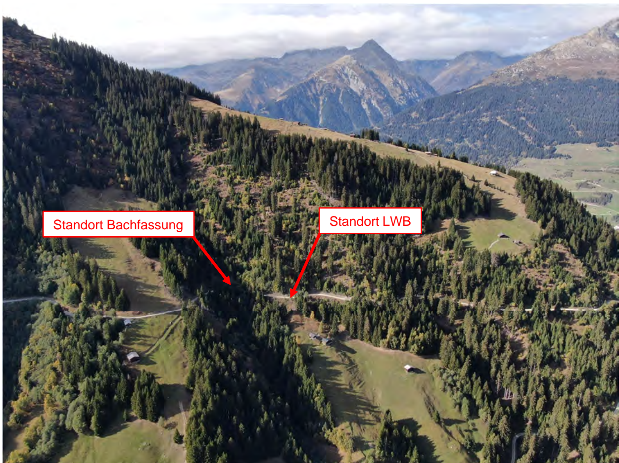
Abb. 4.1 Ansicht Projektgebiet mit Standorten LWB und Bachfassung Chischnès.
