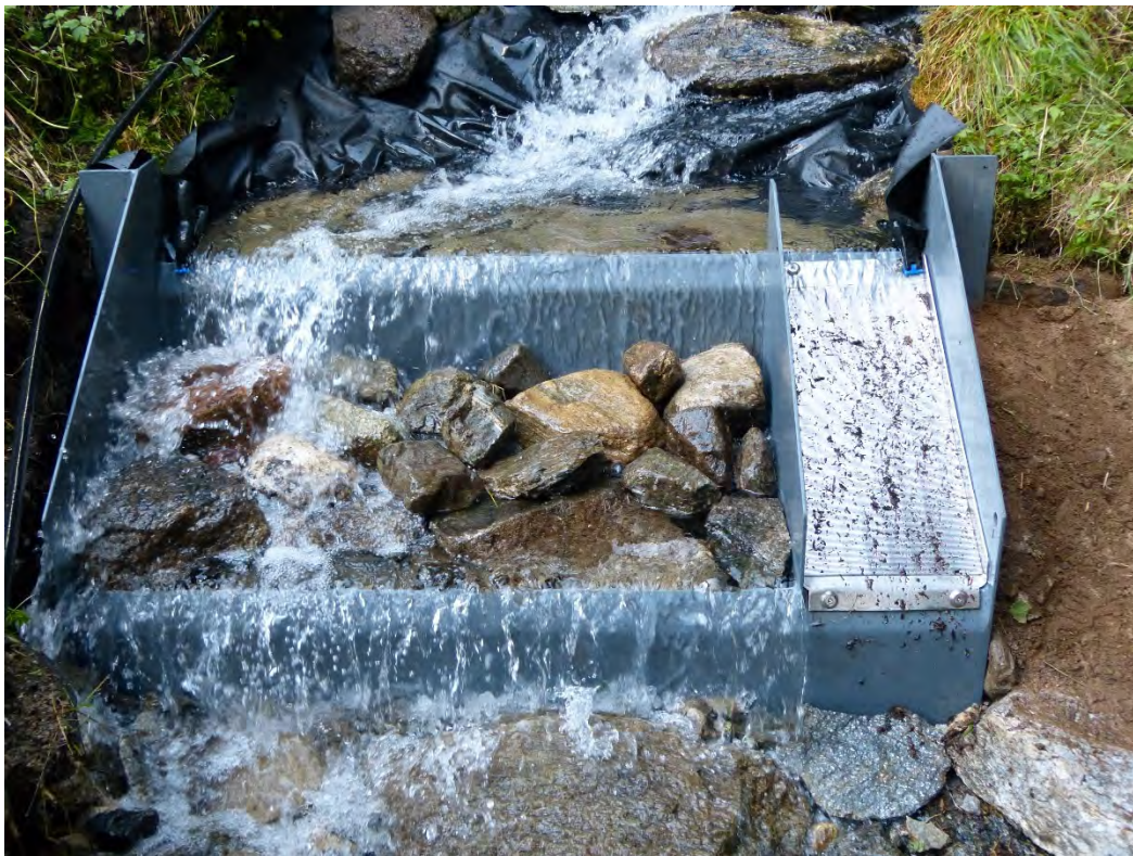
Abb. 4.5 Coanda-Rechen mit Fassungsereich von 20 % (Beispiel).
