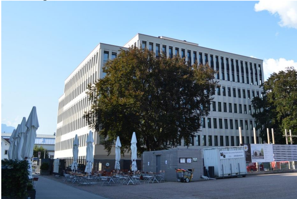
Das neue regionale Verwaltungszentrum in Landquart, Aussenaufnahme.
