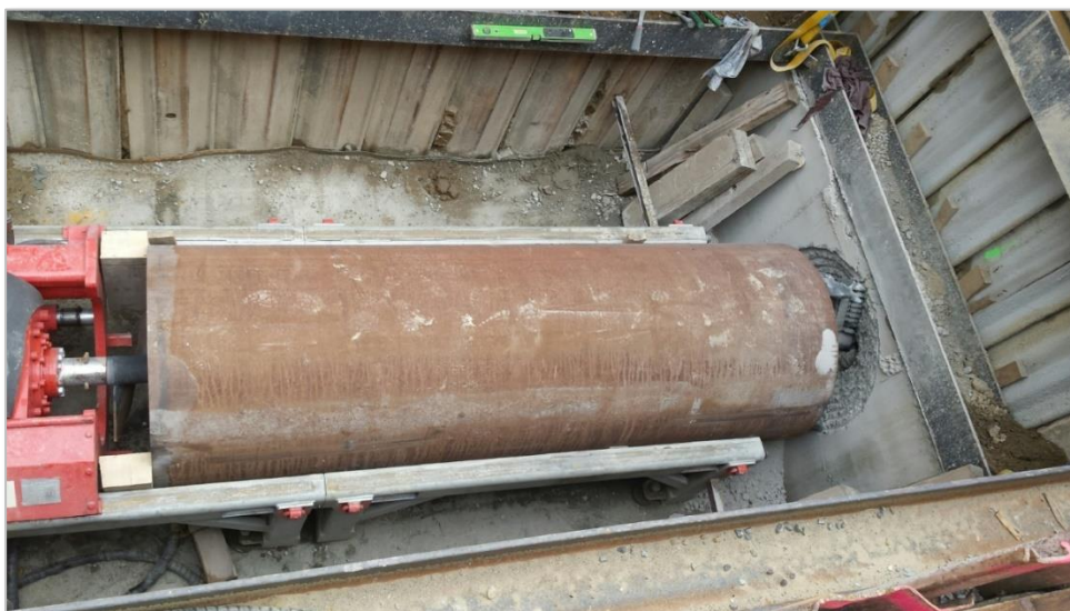
Avanzament cun pressiu
