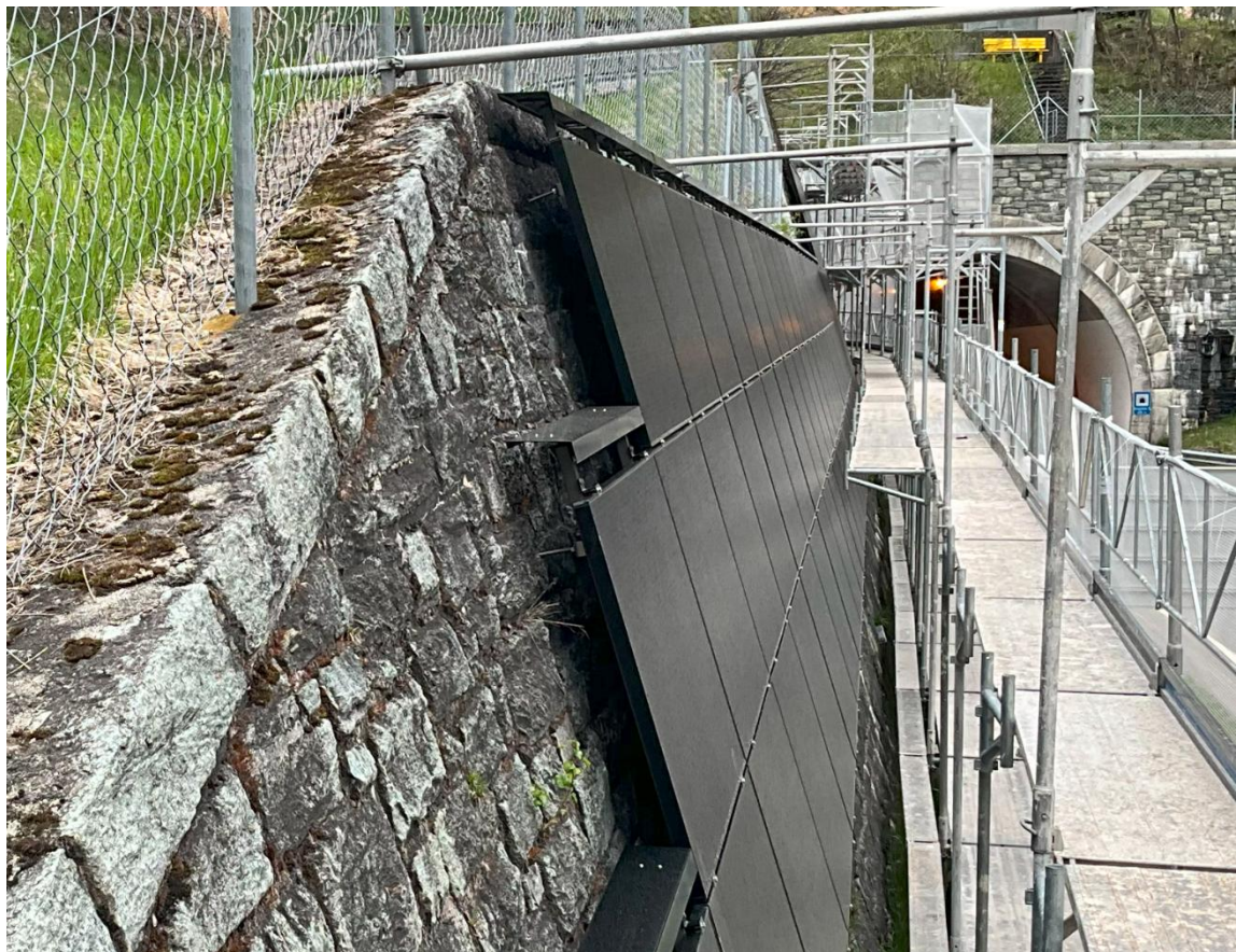
Abbildung 18 Detailaufnahme der Unterkonstruktion während dem Bau
