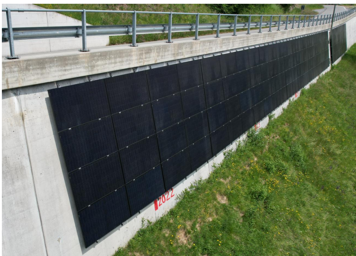
Abbildung 20 PV-Anlage an einer Beton-Stützmauer beim Tunnel Plattas
