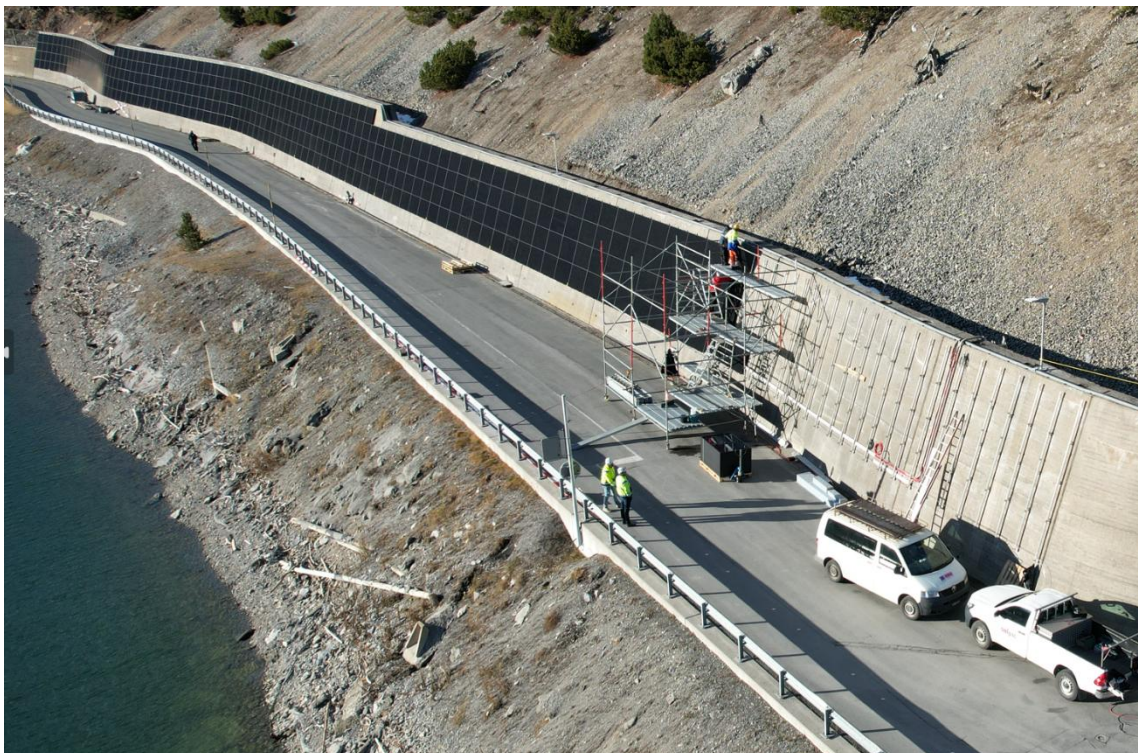
Abbildung 21 PV-Anlage während dem Bau an einer Beton-Wandmauer beim Stausee Punt dal Gall
