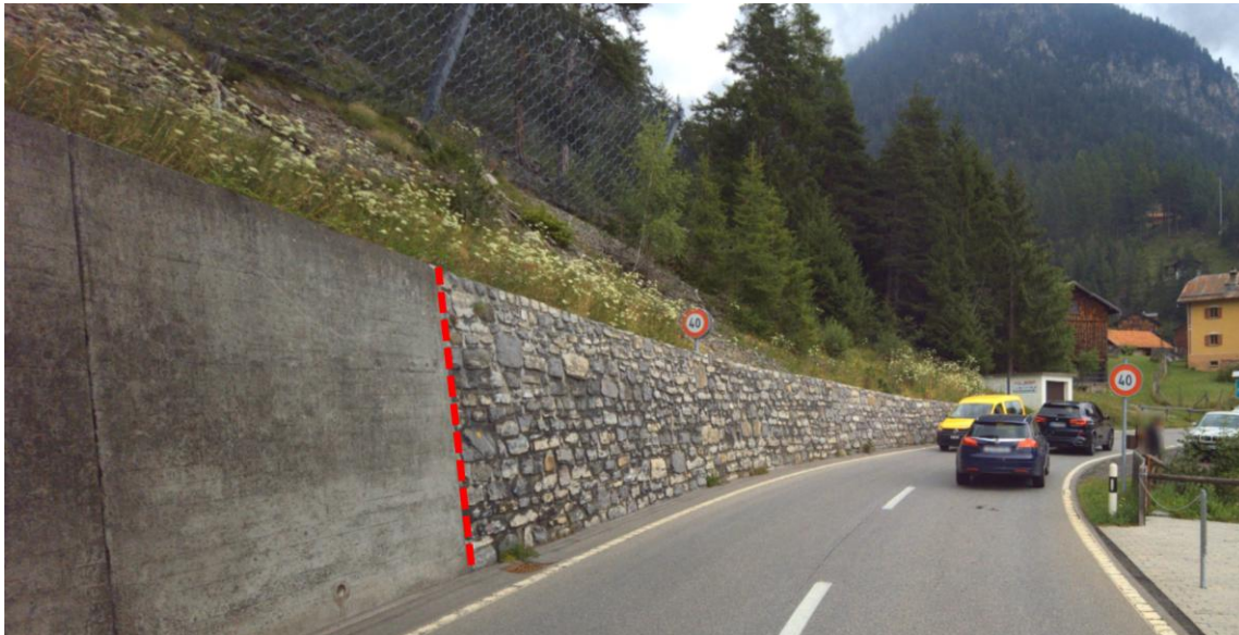
Abbildung 5 Änderung der Bauart / Oberfläche
