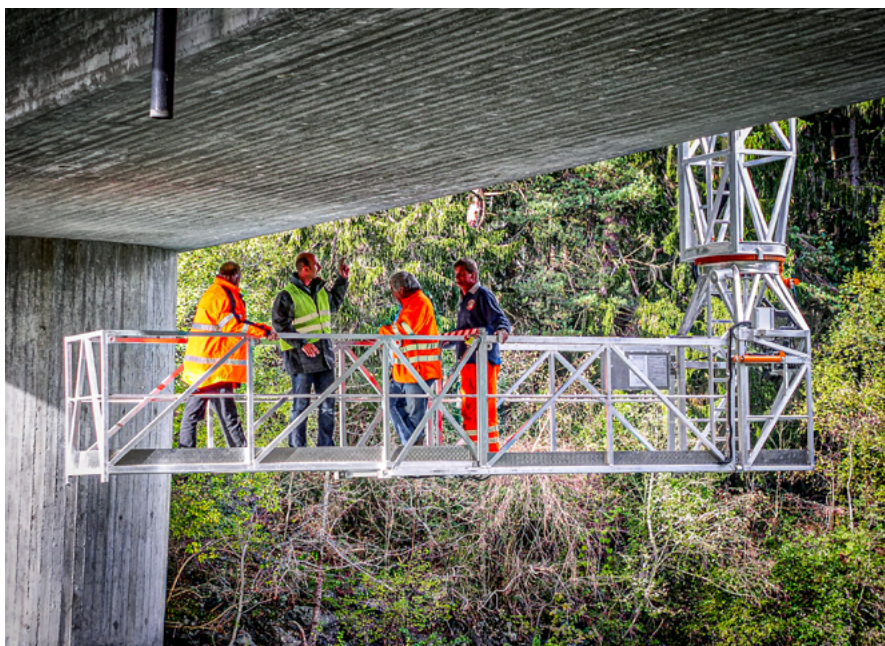
Das Brückenuntersichtsgerät ermöglicht eine detaillierte Inspektion der Brücken.
