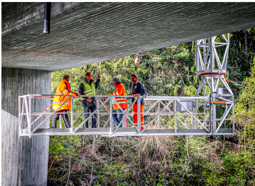
L'indriz per survegliar punts da sutensi permetta da far ina inspeziun detagliada da las punts.
