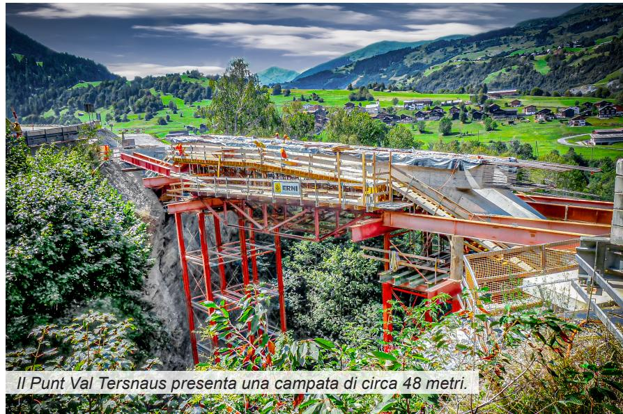
Una particolarità di quest'opera edilizia è la forte inclinazione delle spalle rispetto all'asse del ponte, dovuta alla topografia: per evitare che questa geometria elaborata dovesse essere applicata ai montanti, questi ultimi si restringono notevolmente fino alle loro fondamenta, le cosiddette «imposte». In questo modo, sulla pianta si crea una geometria a V. Lo spessore dei montanti si riduce dal punto di collegamento alla trave principale fino alle imposte da 1,0 m a 0,5 m.
