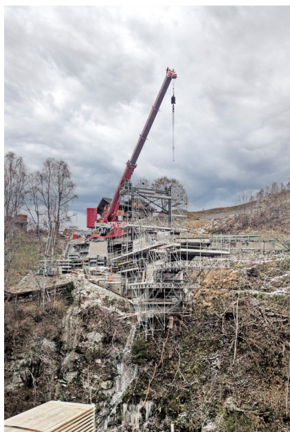
Teilweise montierte Brücke mit Abspannmasten
