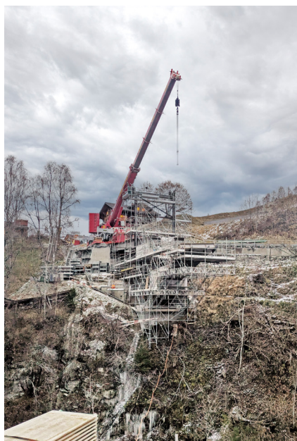
Ponte parzialmente montato con piloni di controvento
