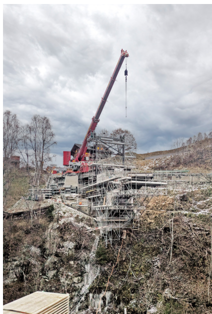
Punt montada parzialmain cun pitgas temporaras
