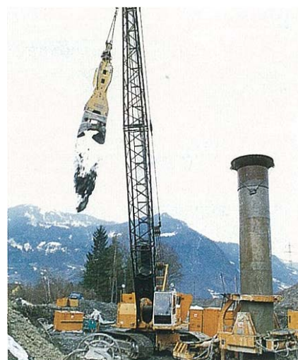
Die Pfahlbohrmaschine in Aktion
