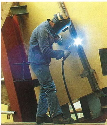
Ein Schweißer beim Zusammenfügen der einzelnen Bogenteile auf der Baustelle
