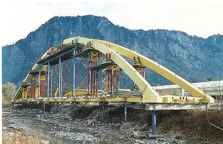
Die Landquartbrücke Au auf dem Montageplatz am linken Ufer der Landquart, kurz vor dem Bogenschluss.
