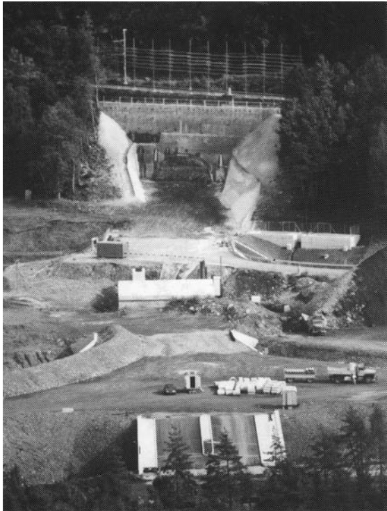
Blick von Thusis her auf den Portalbereich Plattis
