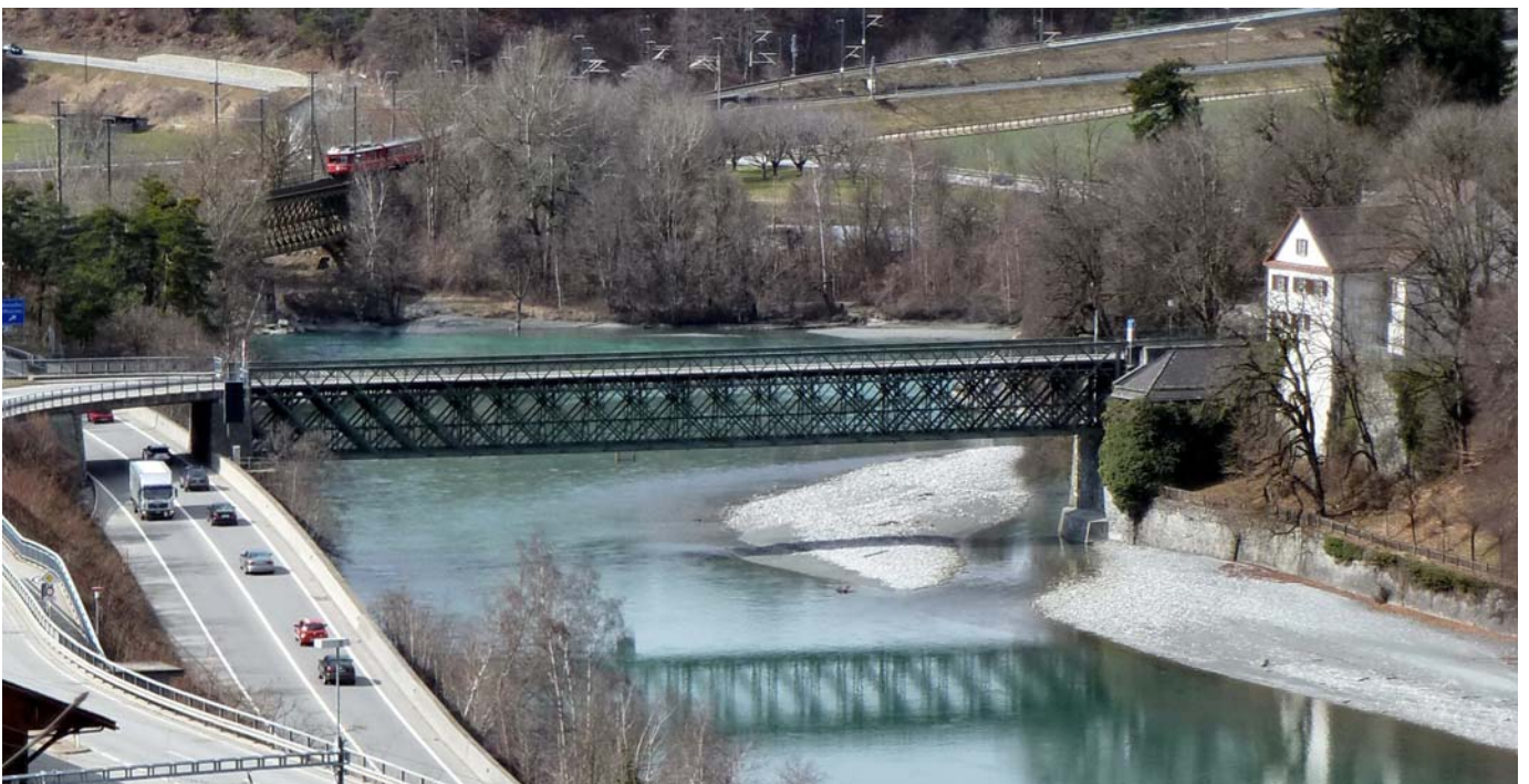
Die Rheinbrücke Reichenau, eine der letzten Eisenfachwerkbrücken aus dem 19. Jahrhundert auf dem Bündner Strassennetz.
