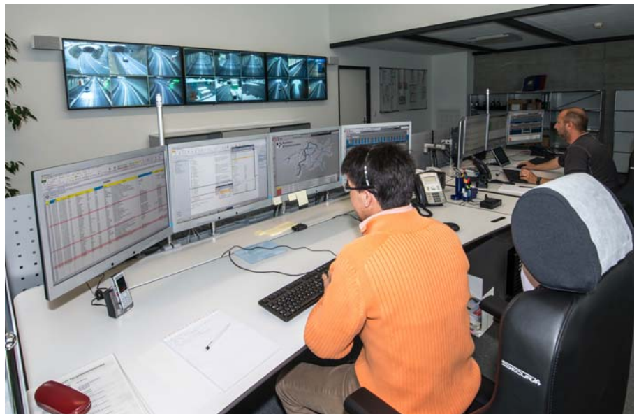
Über Videokameras und Systemmonitore überwachen die Mitarbeitenden in der Betriebsleitzentrale die National- und Kantonsstrassen.
