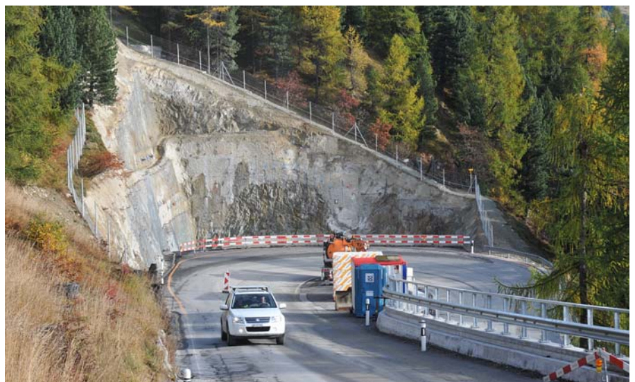
Der Voreinschnitt an der Julierstrasse, bereit für das Anschliessen des Tunnels.
