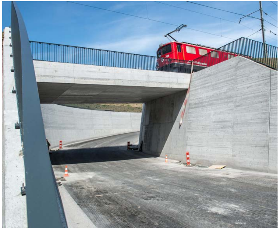
Freie Fahrt für Rhätische Bahn und Strassenverkehr
