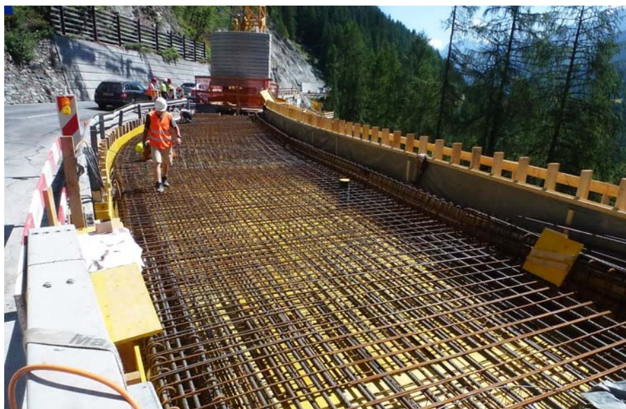
Querschnittserweiterung der Lehenbrücke auf 6.50 Meter
