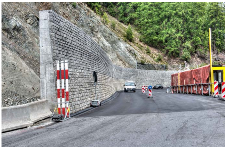
Felsabtrag und Schutzmauer
