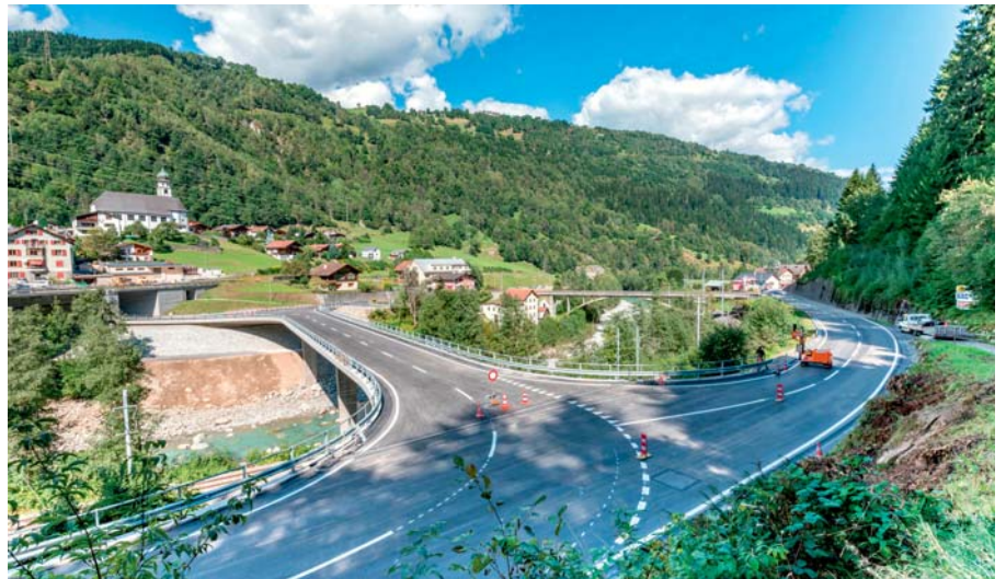
Die neue Vorderrheinbrücke Danis neben der Versellbrücke aus dem Jahr 1928
