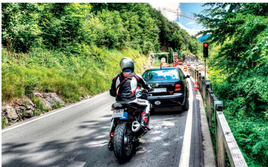
Verkehrsregelung an Baustelle mittels Lichtsignalanlage
