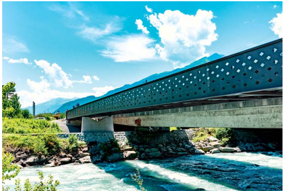
Die neue Rad- und Fusswegbrücke über die Landquart
