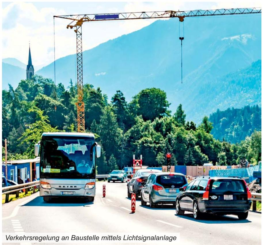
Verkehrsregelung an Baustelle mittels Lichtsignalanlage
