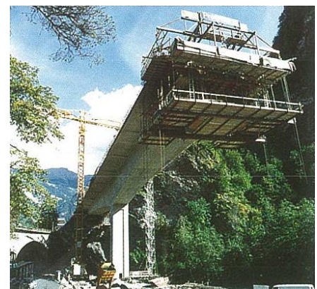
Der Vorbauwagen mit den Arbeitsplattformen und der Schalung am auskragenden Brückenträger
