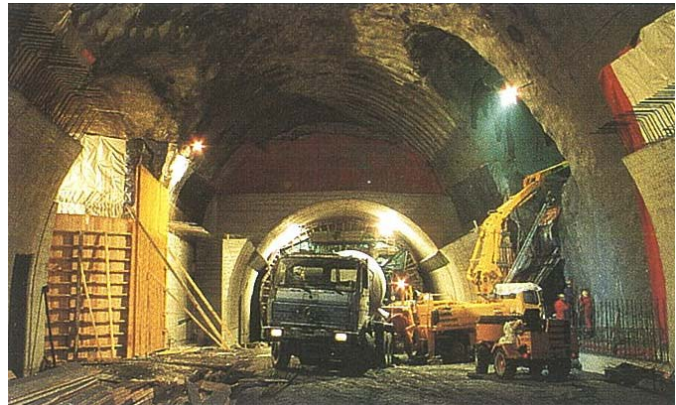
Erstellen der Innenschale im Bereich einer Ausstellnische
