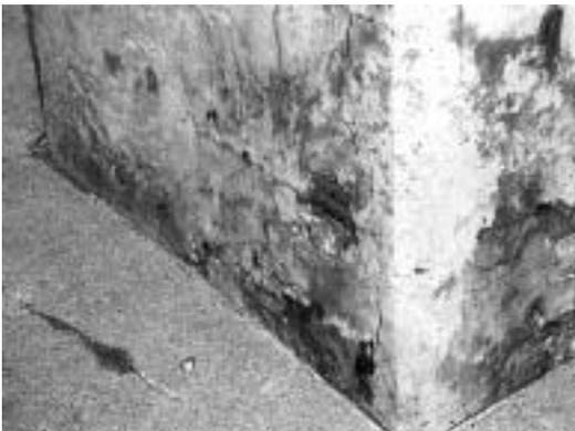
Risse und Betonabplatzungen am Fuss einer Galeriestütze
