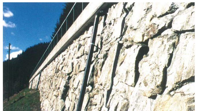
Die aufgesetzte Entwässerungsleitung wirkt improvisiert und störend
