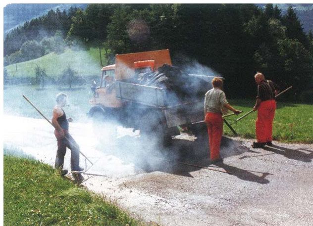
Flicken von Belagsschäden
