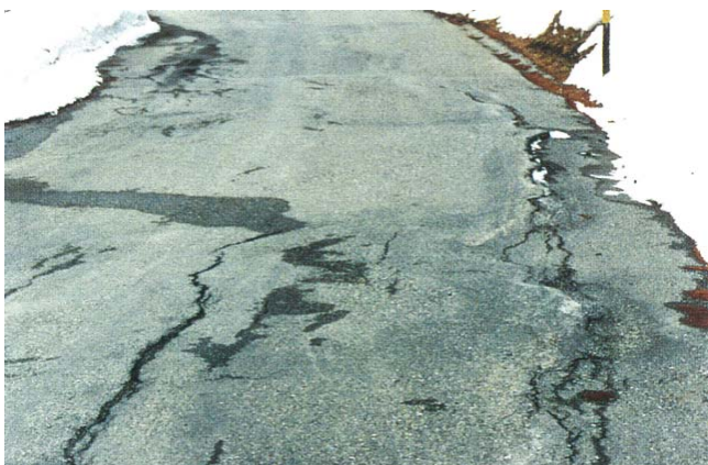
Infolge Eislin senbildung entstandene Frostbeulen mit resultierenden Belagsrisse auf der Julierstrasse.
