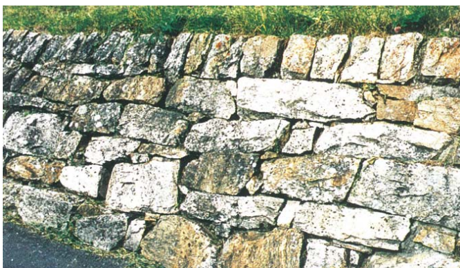
Die sorgfältige Schichtung vermittelt einen stabilen Eindruck
