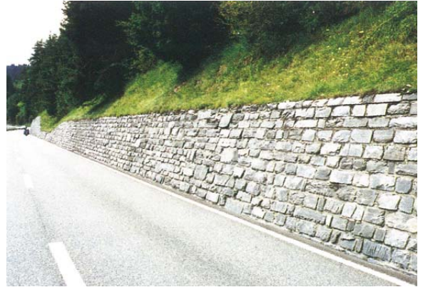
Mauerkrone und Lagerfugen weisen über grössere Strecken die gleiche Längsneigung auf wie die Strasse, was einen ruhigen, schlichten Eindruck vermittelt.
