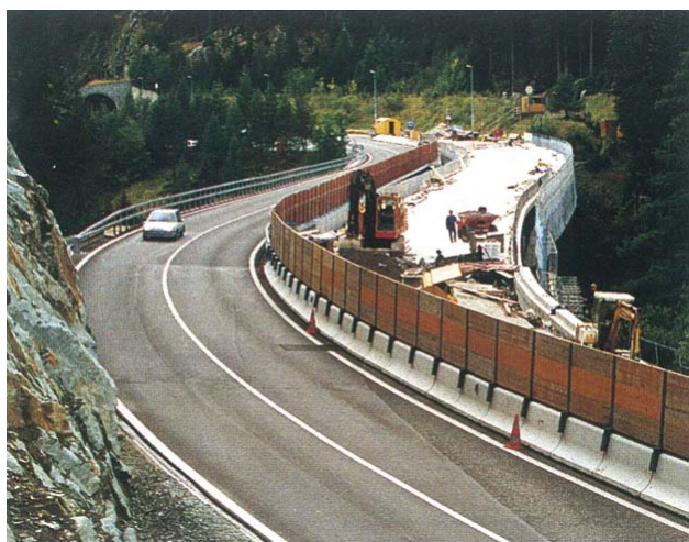
Notbrücke für behinderungsfreie Sanierung auf der A13
