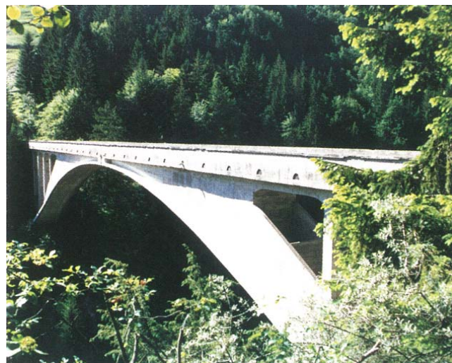
Weltmonument Salginatobelbrücke, gebaut 1929 als innovative Stahlbetonbrücke
