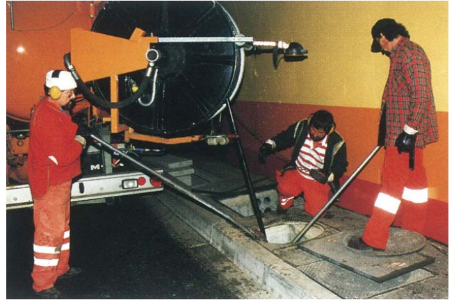
Reinigen der Entwässerungsleitungen in einem Tunnel
