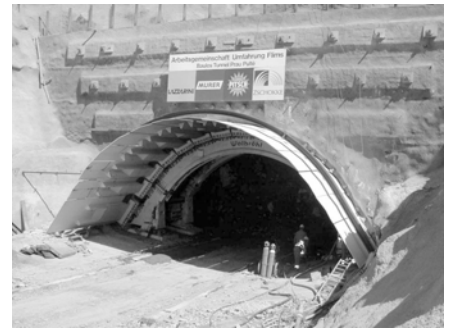
Der Messerschild verschwindet im Prau Pulté Tunnel
