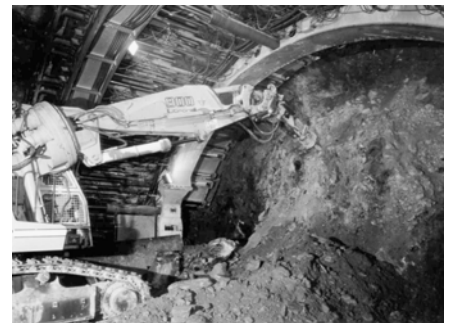
Mechanischer Vortrieb im lockeren Bergsturzmaterial
