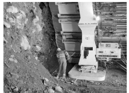
Stützrahmen mit den hydraulisch angetriebenen Messern
