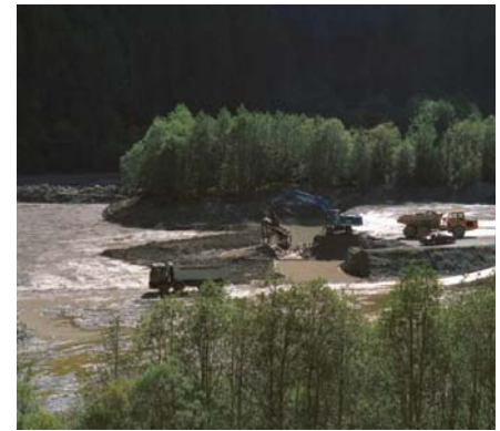
Abtiefen des Umlandes auf die bestehende Flusssohle
