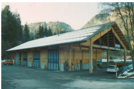
Unterstützpunkt des Tiefbauamtes beim Anschluss Seewis der A28: In den Bezirken 1 Chur und 5 Davos sind sieben Mitarbeiter zuständig für den Unterhalt der A28 mit 230'000 m 2 Strasse und 70 mittleren und grösseren Kunstbauten. Die Schneeräumung erfolgt weiterhin durch Privatunternehmen im Auftrag des Kantons.
