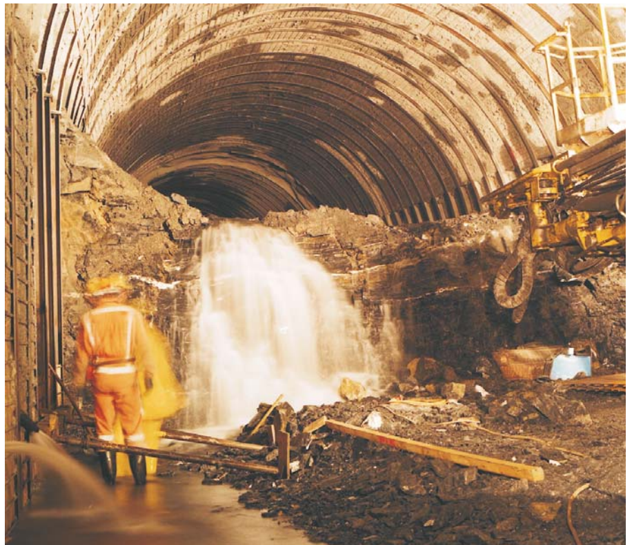
Strossenabbau bei starkem Wasseranfall im Tunnel Flimserstein
