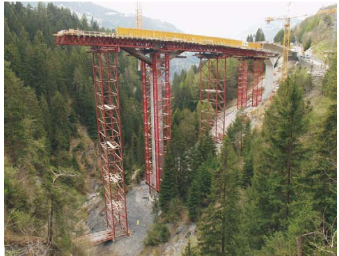
Blick auf die westliche Tobelflanke mit Lehrgerüst und dem bereits betonierten ersten Brückenfeld
