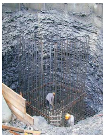
Bau der Pfeilerfundation im bis in den Fels abgetieften Schacht
