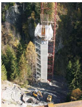
Fundament- und Pfeilerbau im steilen Castielertobel
