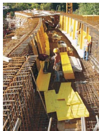
Armieren und Schalen des Brückenkastens
