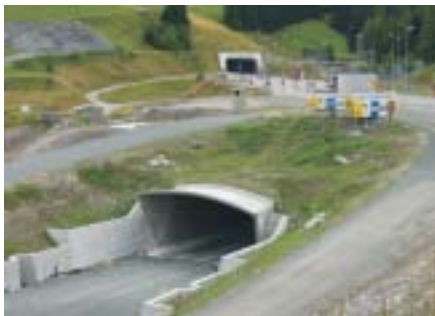
Portal des Gotschnatunnels in Selfranga, Herbst 2003
