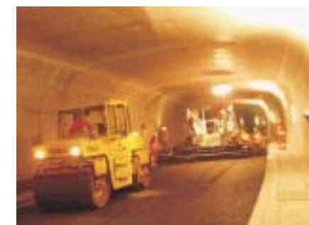
Einbau der ersten Meter Belag im Gotschnatunnel, September 2003
