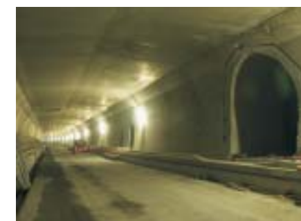
Gotschnatunnel mit Querstollen zum Sicherheitsstollen, August 2003
