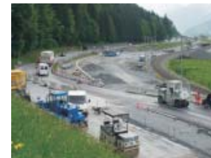
Trassearbeiten beim Anschluss auf dem Büel, Juni 2003
