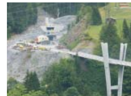
Die eingeschüttete Tagbaustrecke mit Portal im Drostobel, Frühling 2003
