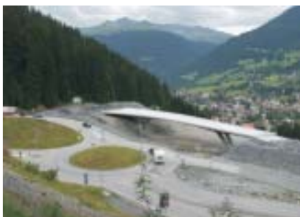
Provisorischer Kreisel und Brücke Bim Bad in Selfranga, Juli 2003
