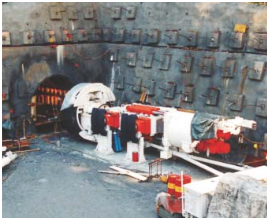
Montage der Tunnelbohrmaschine im Voreinschnitt Drostobel
