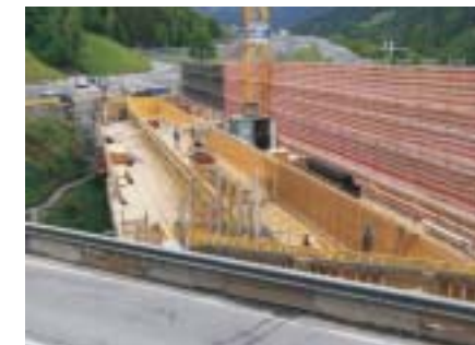
Schalen und Armieren der Saasalpbachbrücke, Mai 2002
