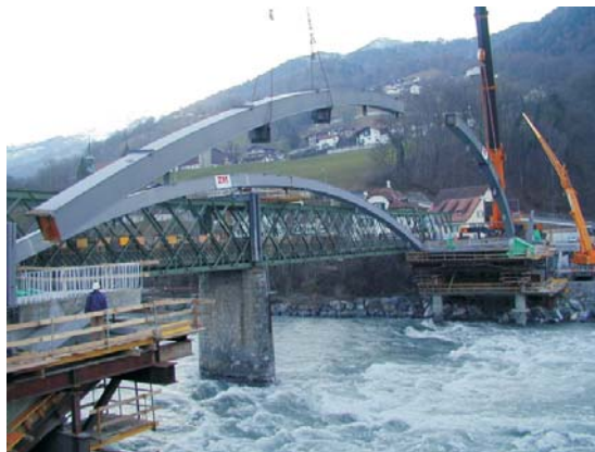
Montage der zwei Stahlbögen als Haupttragelement der neuen Rheinbrücke
